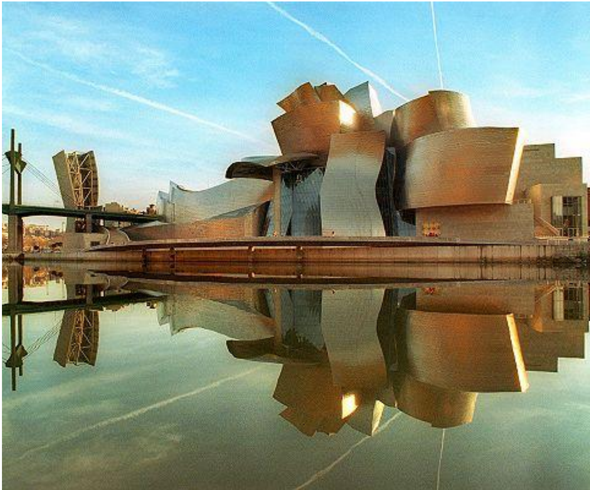
Guggenheim Museum Bilbao (1997, Bilbao, Španělsko)
