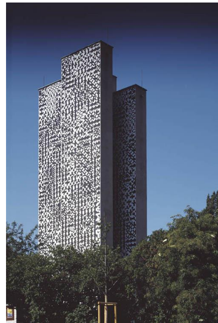
„Mozaika na větracích komínech Letenského tunelu“ - 1969
